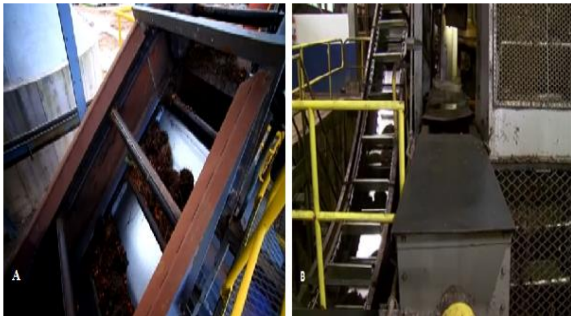
Figura 38: Equipamentos de processamento do óleo de dendê.
