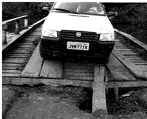
Figura 53 – Condições de algumas pontes
